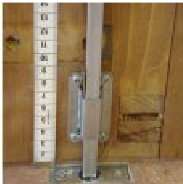
Verankerung Sprossenwand unten (zum Ausklappen)
