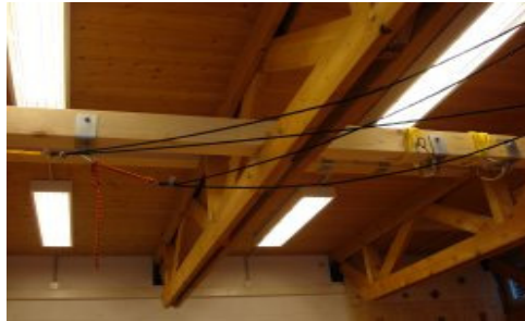
Verankerung und Haken an Balken, Psychomotorik-Raum Schulhaus Oberzil
