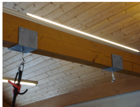
Hakenmontage Kindergarten Achselweg
